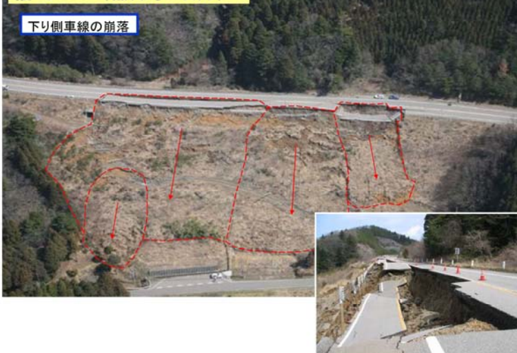
写真-3. 1. 1 (b) 能登有料道路地震被害状況写真 (6. 3kp、縦-9)
