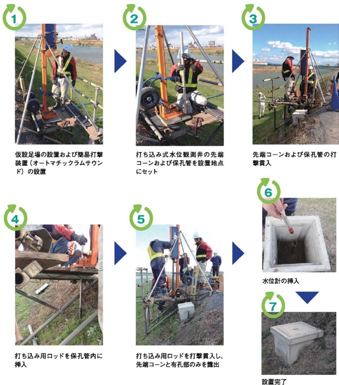
図-3.2.10 打ち込み式水位観測井の設置手順
