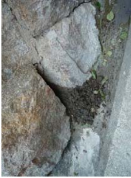
石間からの土砂の抜け出し
