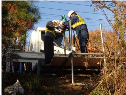
写真-3.4.6 バイブロハンマーによる簡易サンプリング実施状況
