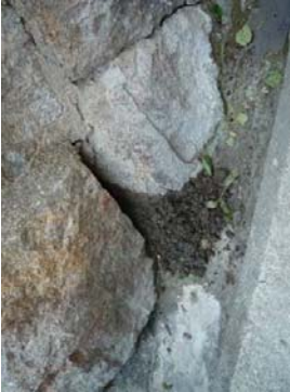
石間からの土砂の抜け出し
