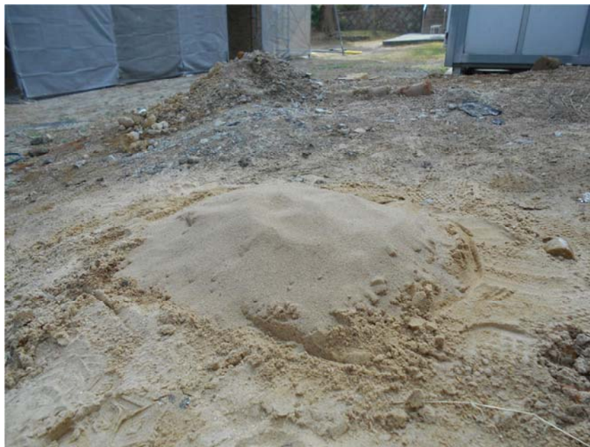
図 4-13 模擬剛体設置箇所の敷き砂状況
