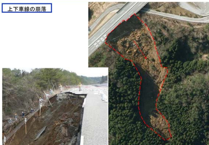
写真-3.1.1(g) 能登有料道路地震被害状況写真 (17.7kp、縦-32)
