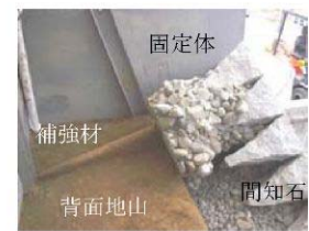
図－7.2.11 ピンナップ工法の施工概要 15)
