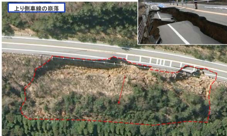
写真-3.1.1(f) 能登有料道路地震被害状況写真 (15.9kp、縦-26)
